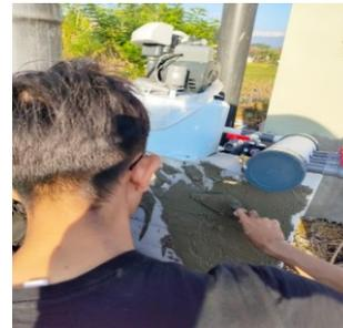
**Gambar 5a:** Pembuatan pondasi sistem
